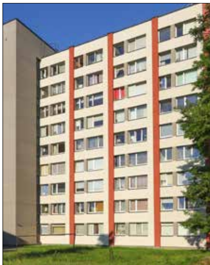
Renowacja bloków wielomieszkańczych na Litwie. Fot. z archiwum APVA
