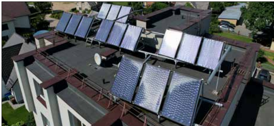
Renowacja bloków wielomieszkaniowych na Litwie Fot. z archiwum APVA
