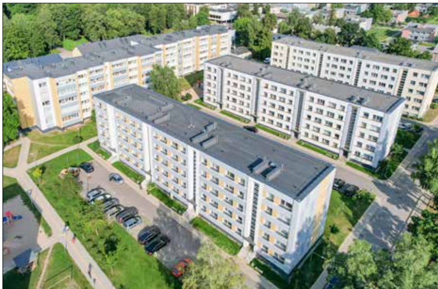
■ Renowacja domu wielomieszkaniowego na Litwie Fot. archiwum APVA
