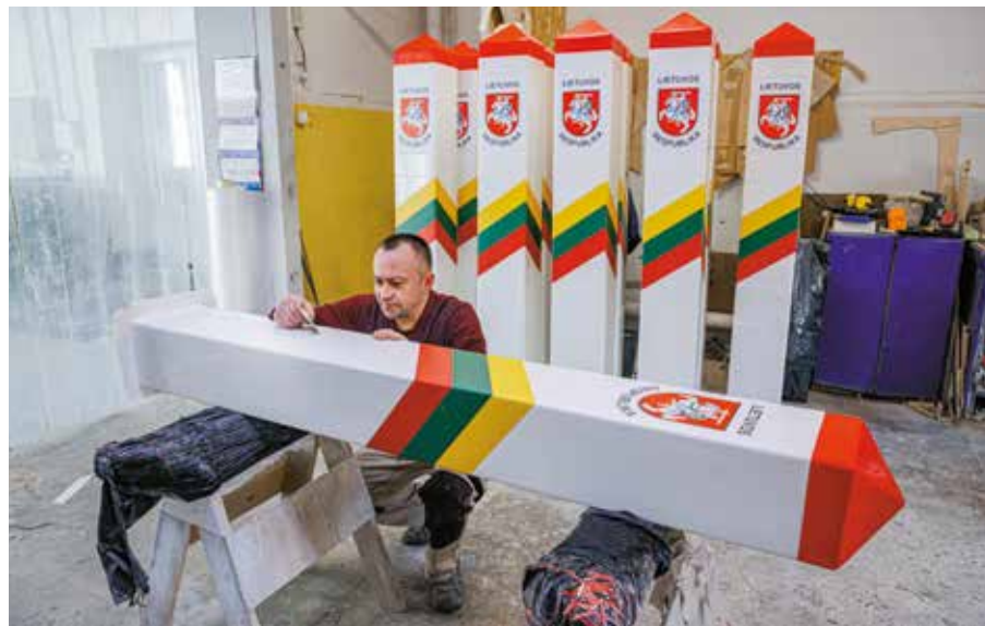
W UBIEGŁYM ROKU FIRMA OTRZYMAŁA ZAMÓWIENIE NA WYKONANIE SŁUPKÓW GRANICZNYCH , które rozdziela Litwę i Białoruś.
