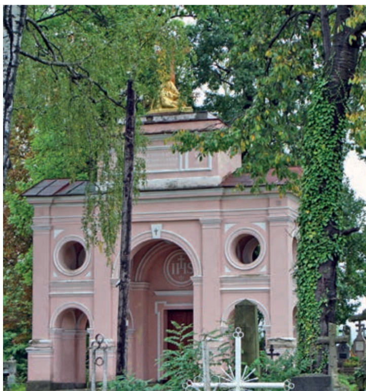
KAPLICA JEZUITÓW W CHYROWIE NA MIEJSCOWYM CMENARZU
