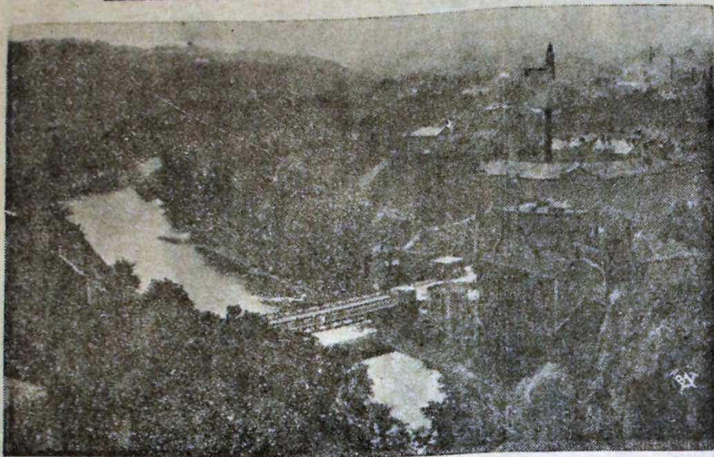
Ogólny widok na Olzę i most łączący Cieszyn Polski z częścią miasta po czeskiej stronie
