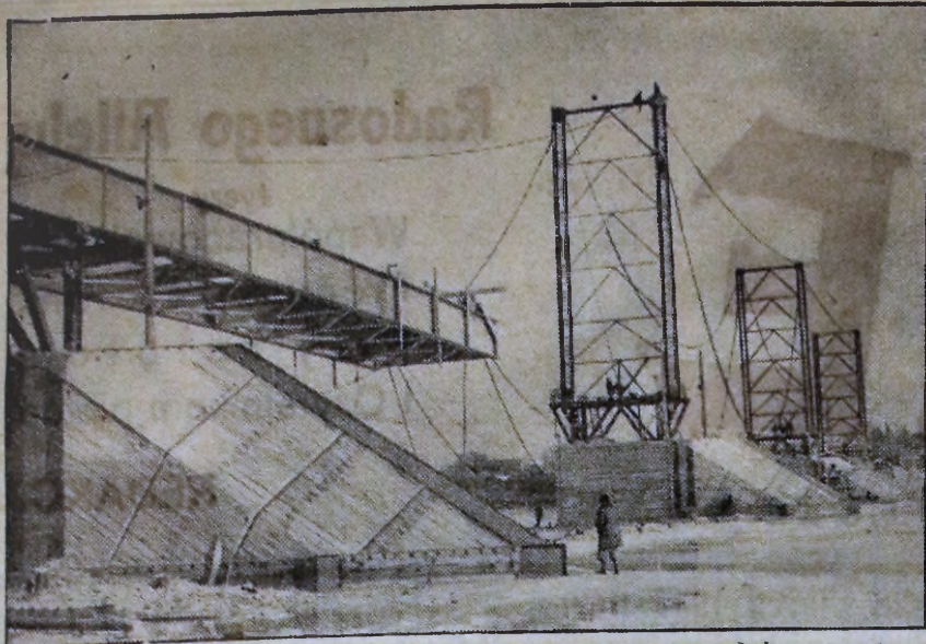
Na lewo: Fragment nowo- wzno- szo- nych budo- wli w Ke- gumsio na Daugawie. Na zdjęciu widoczno są oparcia, na których uło- żony zosta- nie most, budowany w miejscu, gdzie pow- staje ta po- tężna hy- droelek- rownia w Łotwie
