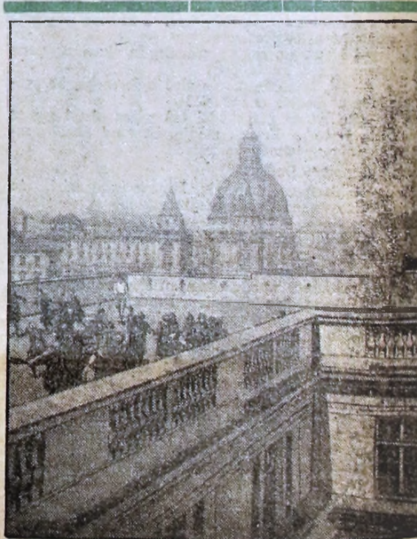
Taras dla zabaw na dachu gmachu gimnazjum im. Królowej Jadwigi. — W oddali widać kopułę kościoła św. Aleksandra, Warszawa.
