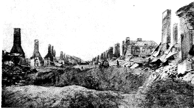
Gruzy Garwolina we Wrześniu po bombardowaniu niemieckim. Podobnie wyglądają teraz dzielnice fabryczne Kolonii.☞
