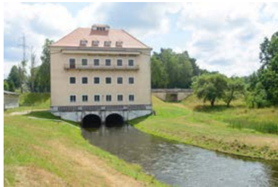
Elektrownia wodna w Krzyni (fot. K. Rolbiecki)
