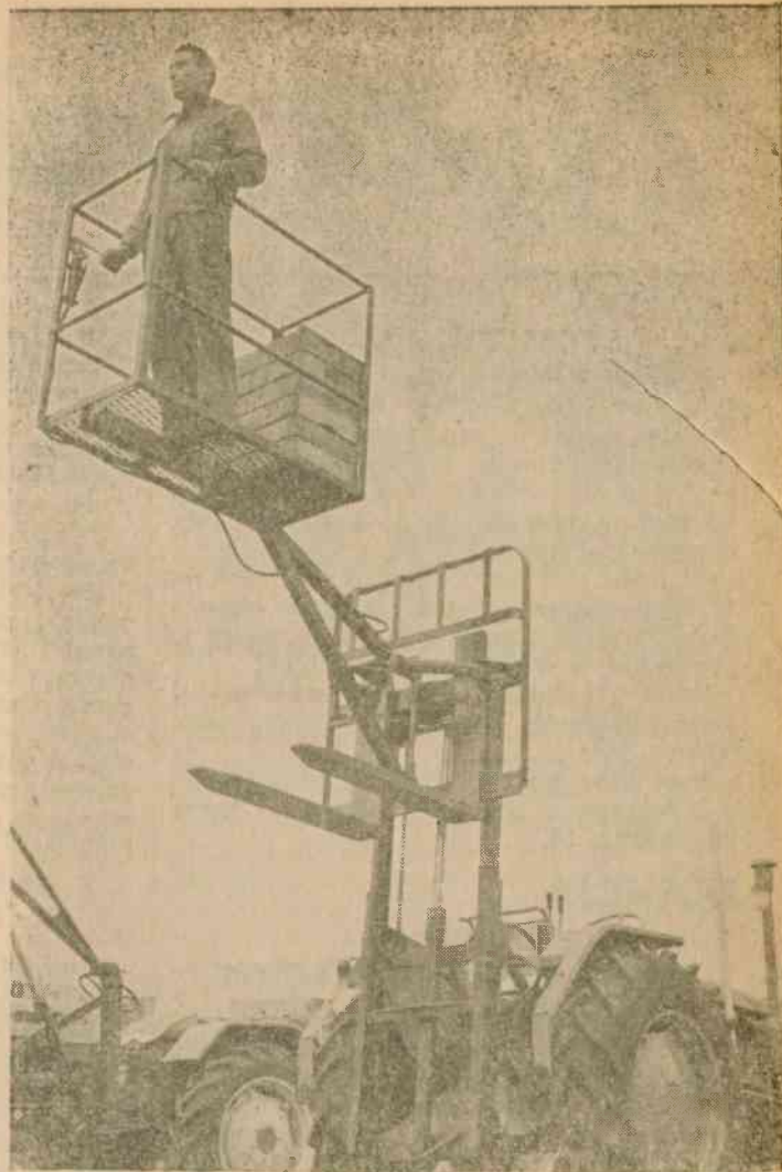
Nowość w Salonie Maszyn Rolniczych: Ten oto aparat otrzymał nazwę „Sierpa snopów”, ułatwia on zbiór ow-ców i pozwala na kilku piętrach przewozić wielkie ładun-ki. Przyczepia się go z tyłu traktoru.
