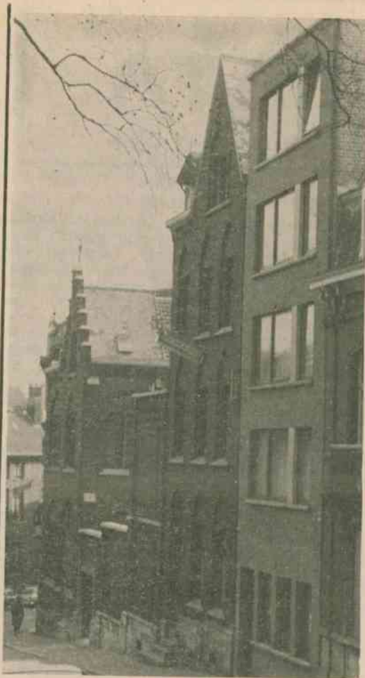
Kompleks domów Kapelanii Cudzoziemców na rue des Anglais w Liège. Na pierwszym planie nowa konstrukcja, w której zamieszkuje księża
