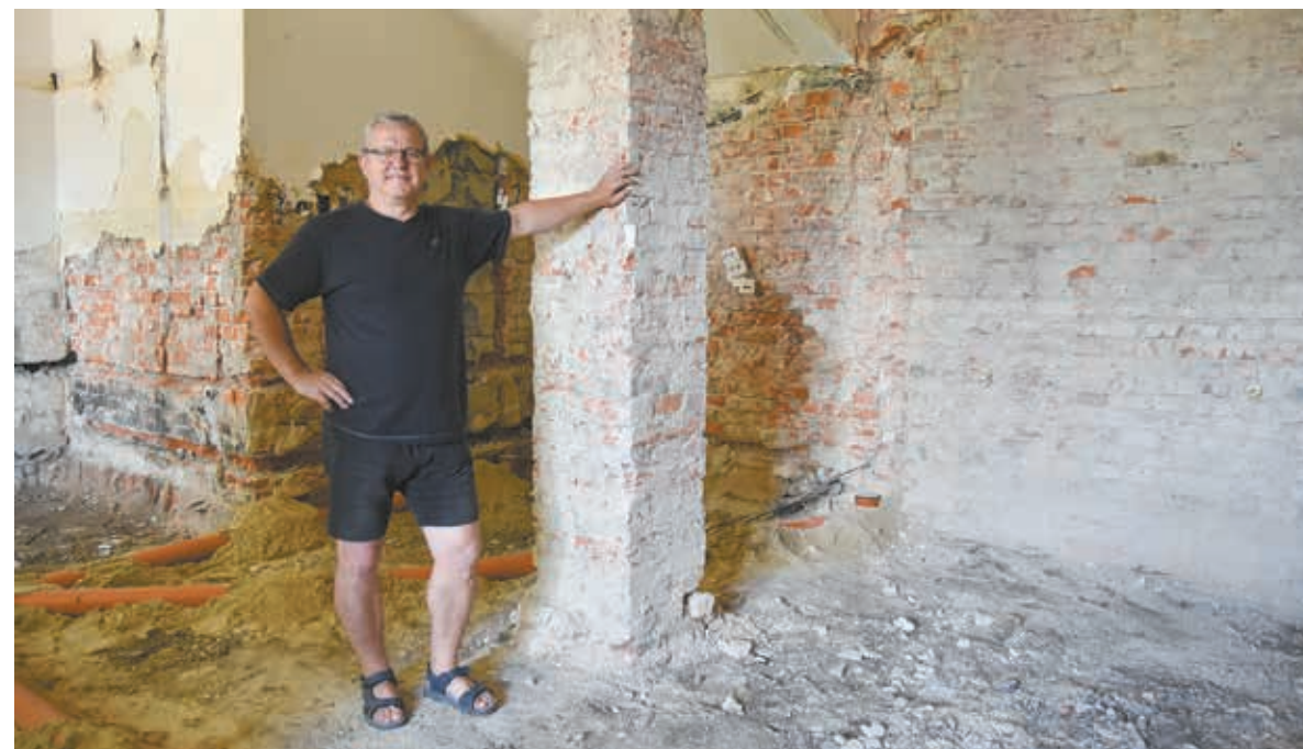
• Janusz Ondraszek pokazuje remontowaną obecnie część budynku. Fot. DANUTA CHLUP
