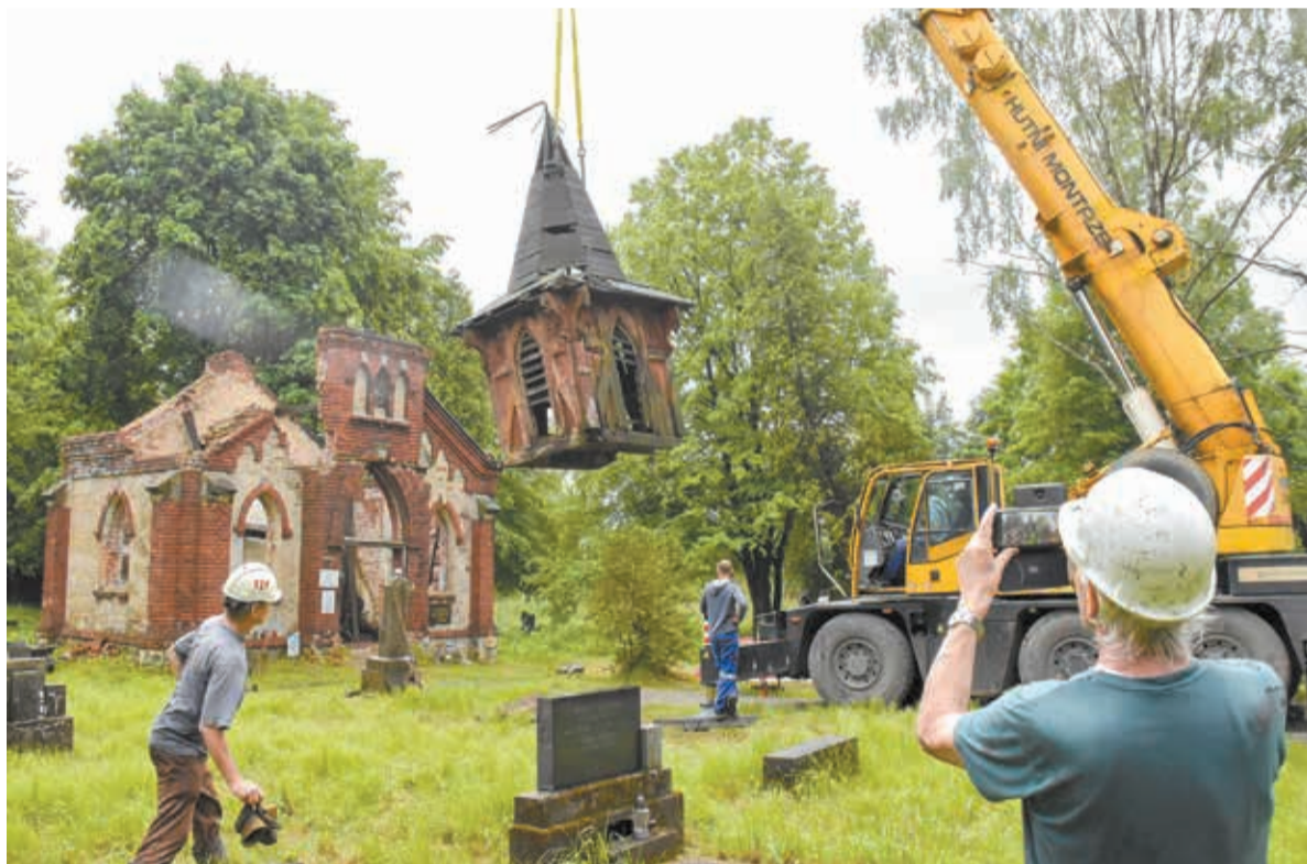
• Odpowiednie zabezpieczenie wieży przez społeczników z Olza Pro sprawiło, że bez szwanku została wyciągnięta z murów kaplicy. Środowe przedsięwzięcie wyciągnięcia wieży ma zostać sfinansowane przez Konsulat Generalny RP w Ostrawie. Fot. ŁUKASZ KLIMANIEC
