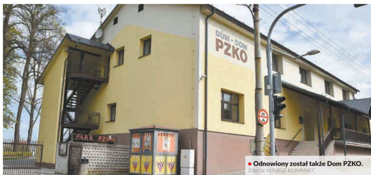
• W planach jest m.in. modernizacja budynku Urzędu Gminy.
