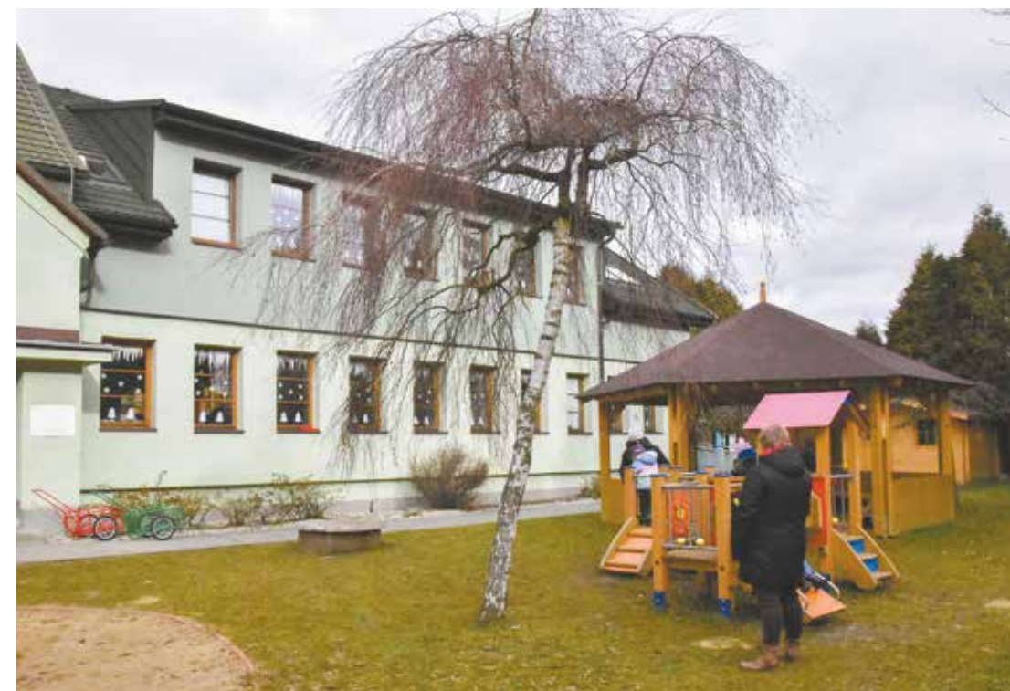
• Polskie przedszkole zyskało m.in. nową elewację, dach i sale do prowadzenia zajęć z dziećmi.
