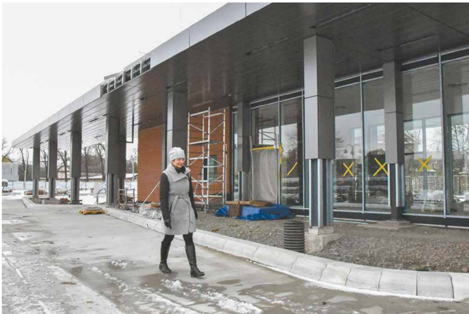
• Budowa nowoczesnego terminala autobusowego z formułą park&ride to jedna z najważniejszych inwestycji miejskich.
