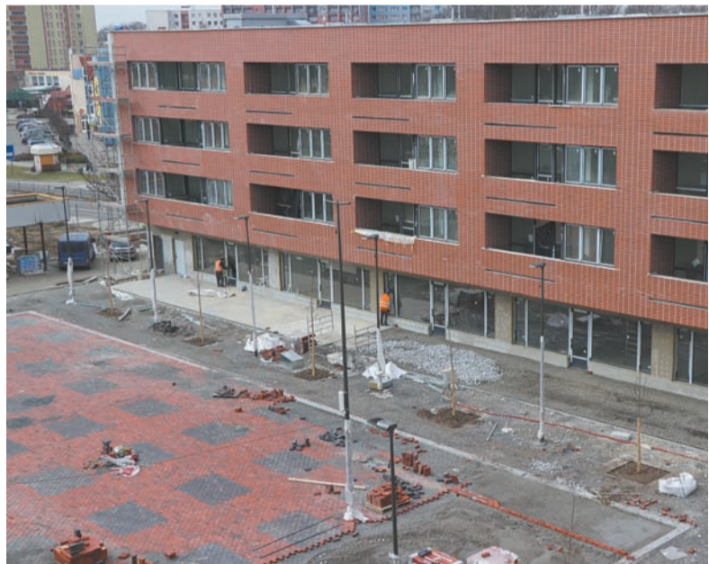
● Budowa rynku. Widok na dom wielofunkcyjny. Fot. ARC
