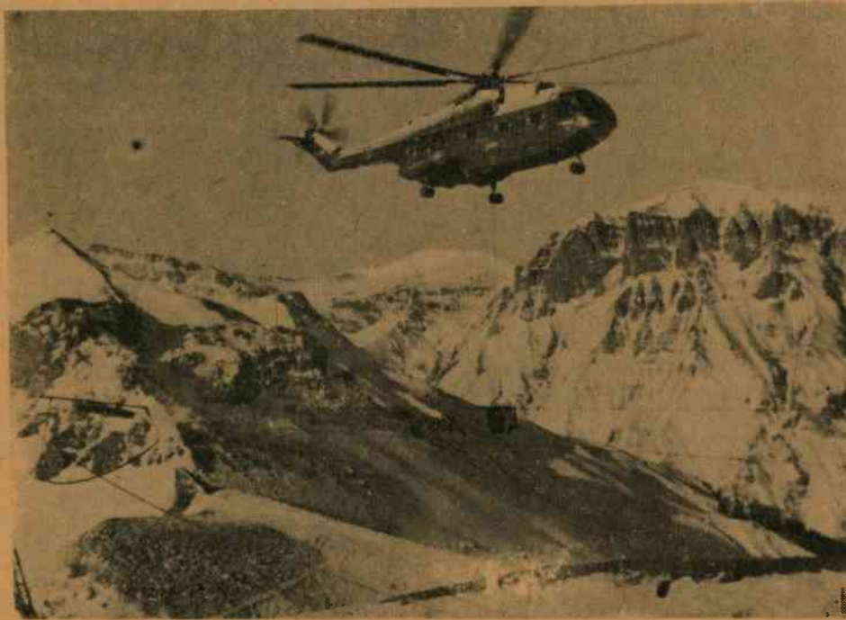
Helikoptery należą do najużyteczniejszych środków transportu. Zdjęcie przedstawia helikopter transportujący dwutonowy kabel w terenie górskim na wysokość 2500 metrów
