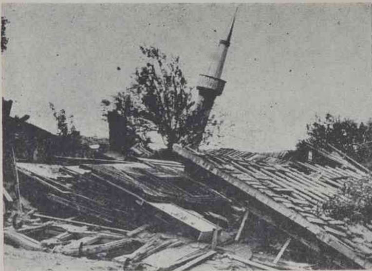
Akurat w tej części Turcji, którą już nie raz nawiedzały katastrofy, ostatnie trzęsienie ziemi zniszczyło 4 prowincje. Z miasteczka Varto pozostała sterta gruzów. Zginęło parę tysięcy ludzi i nie mniej zostało rannych.
