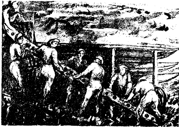
Budowa mostu Baileya
