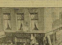
W Rotterdamie, w Holandji zawałła się część domu. Pod gruzami znalazło śmierć ósmo osób, a 40 zostało rannych. — Na zdjęciu między katastrofą.
