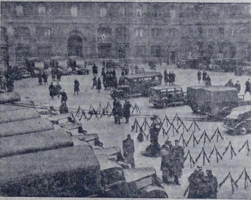
Na zdjęciu widok podwórza głównej kwatery policyjnej w Paryżu...
