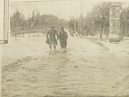
Wskutek wezbrania wód w rzece Sajó, górna część Węgier nawiedziła katastrofalna powódź. Woda zalała liczne wioski i pola uprawne, niszcząc m. in. most kolejowy na linii Banrewe — Ozd. Szkody są bardzo wielkie.
