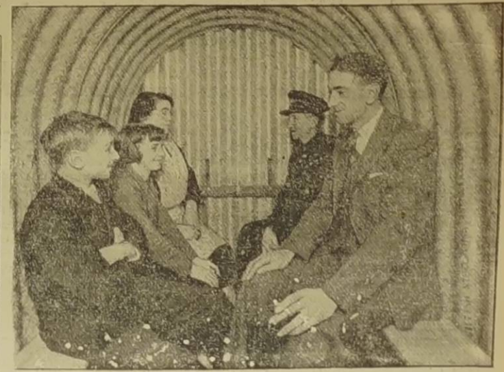
Schron przeciwlotniczy ukończony. Rodzina zajęła miejsca w jego wnętrzu i czuje się bardzo zadowolona. Ze względu na wypadek nalotu lotniczego ma zagwarantowane bezpieczeństwo.
