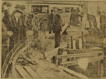
Budowa tych schronów, mających służyć ludności za schrony przed atakami samolotów nieprzyjacielskich w czasie wojny, jest już na ukończeniu. — Na zdjęciu fragment z wejścia do tunelu, utworzonego z grubych wieńców rur stalowych, pokrytych ziemią, obok stacji kolej podziemnej South Kensington.
