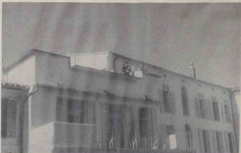
Część zabudowań klasztornych przeznaczona dla osób świeckich. Na tarasie - goście korzystający z wypoczynku wakacyjnego.
