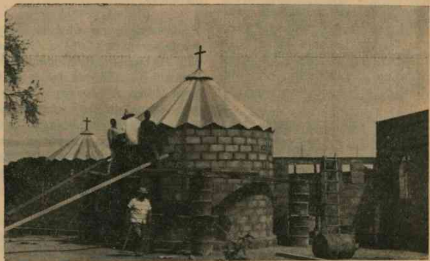
Śp. Brat Stanisław przy budowie kościoła w Figuil
