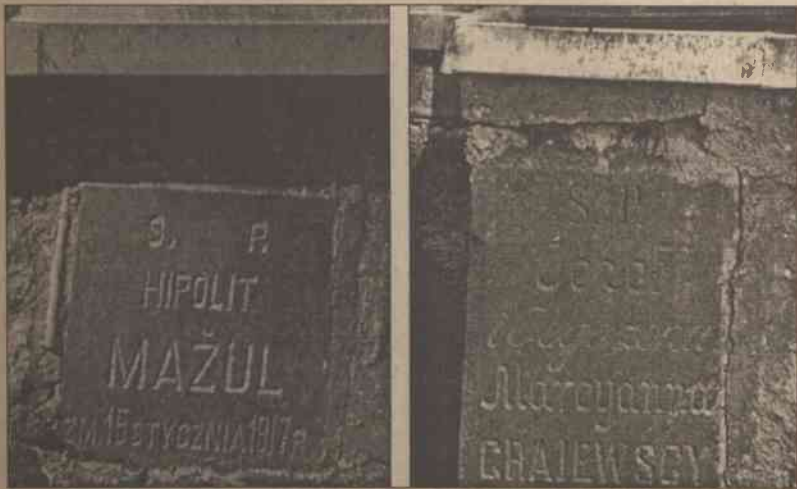
Kościół stanął na cmentarzu, nagrobków nie wyrzucono, powstał z nich unikatowy fundament
