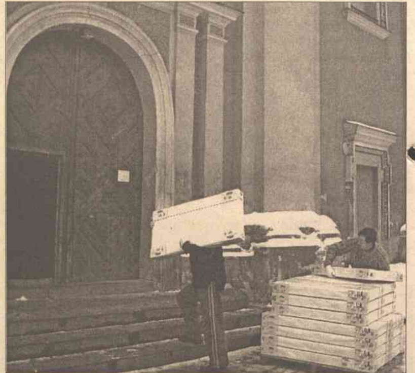
Rozpoczęły się prace remontowe przy podgrzewaniu podłogi w kościele pw. Wszystkich Świętych Fot. Zbigniew Markowicz
