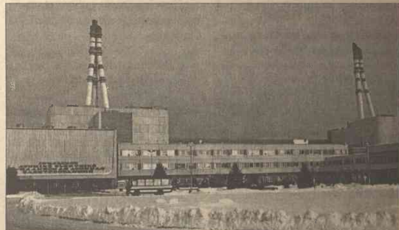
Zamknięcie elektrowni w Ignalinie było jednym z warunków przystąpienia Litwy do Unii Europejskiej Fot. ELTA
