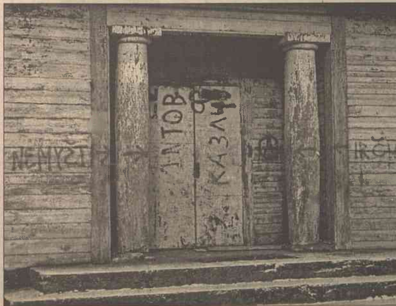
Czy z opuszczonych budynków nie będzie już żadnej korzyści? Tak wygląda wejście do byłej szkoły im. Piłsudskiego
