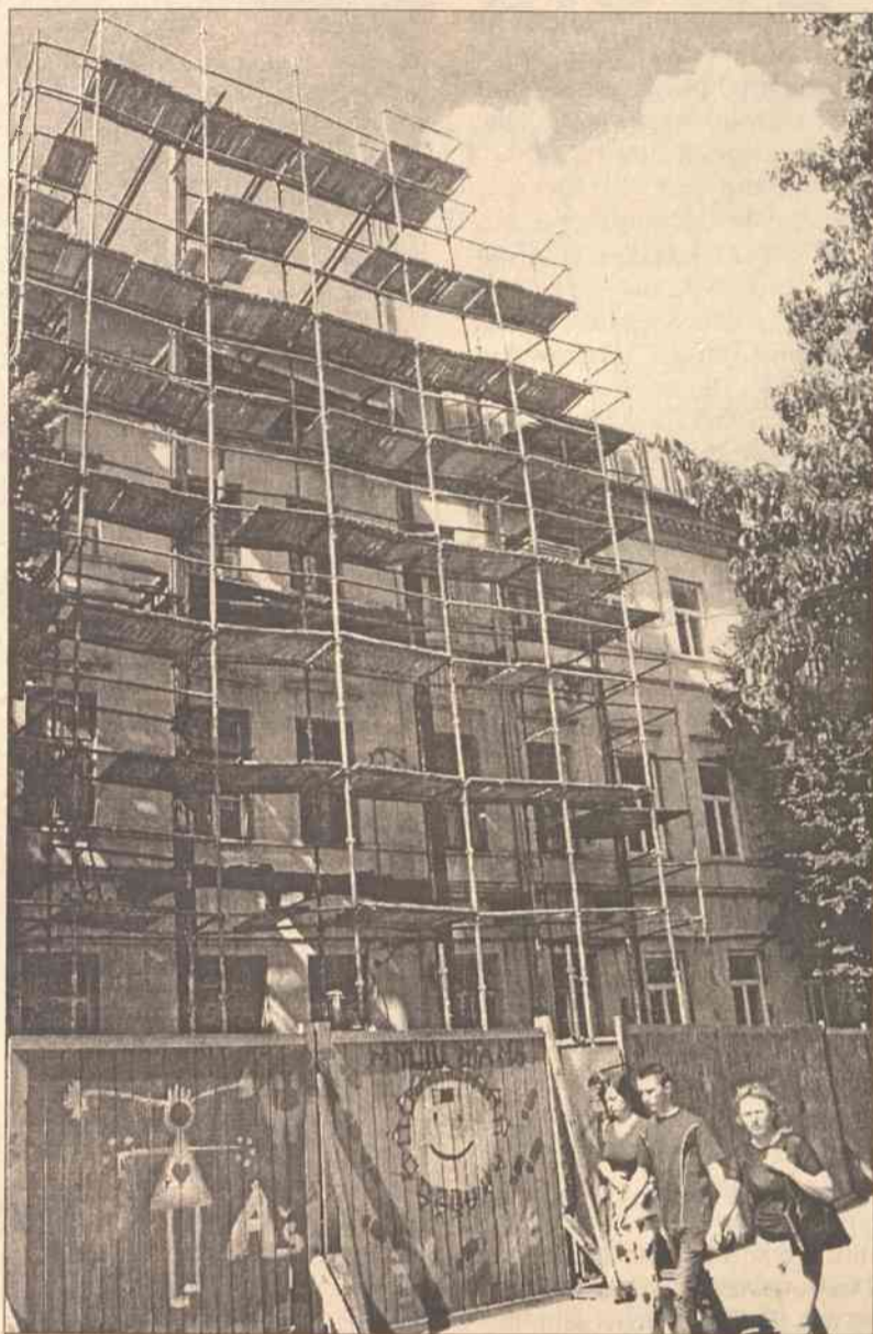
Rusztowania — to nadzieja na odnowę
