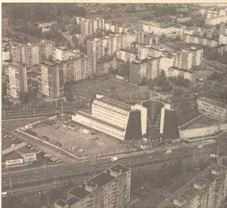
Rząd zatwierdził nowy program finansowania modernizacji domów wielomieszkańczych Fot. ELTA
