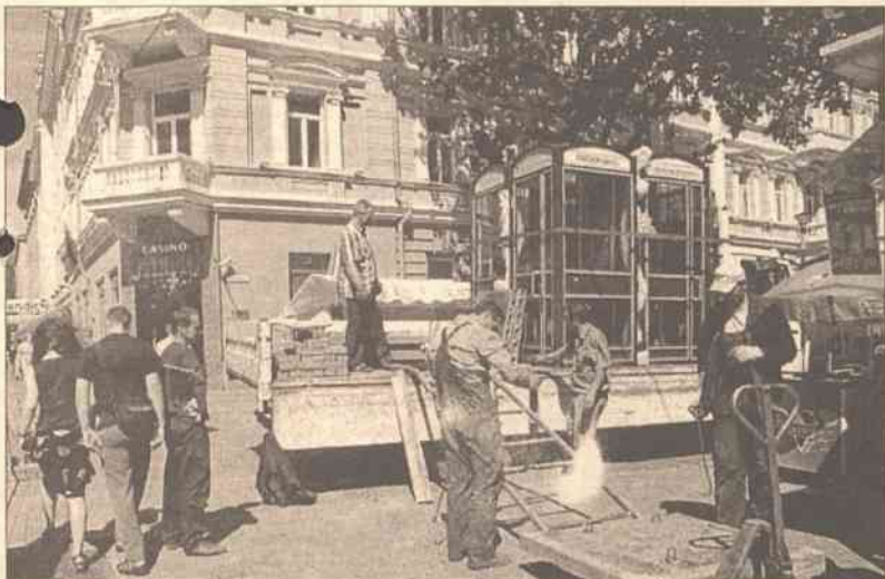
Prace na drugim odcinku alei już się rozpoczęły
