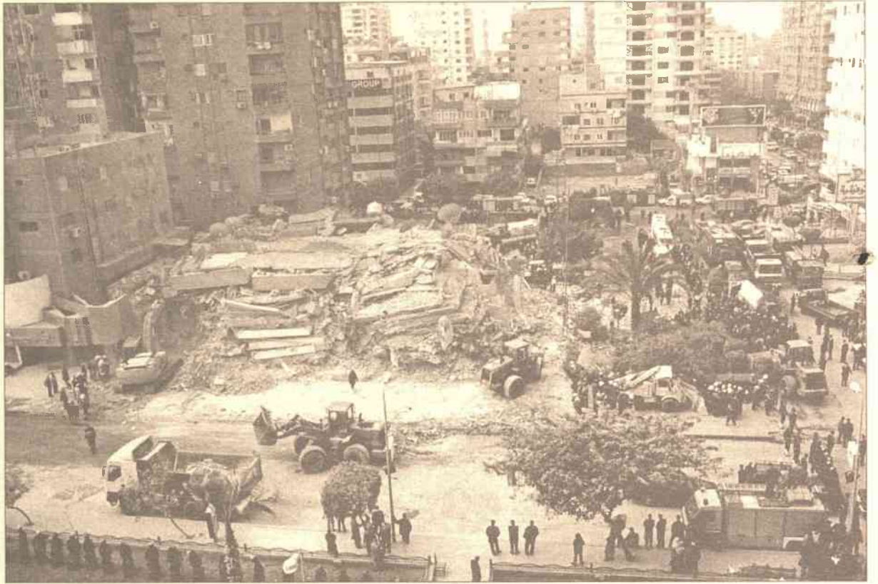
Pożar wybuchł w jednym ze sklepów na parterze i naruszył całą konstrukcję budynku, który jak domek z kart złożył się pod własnym ciężarem
