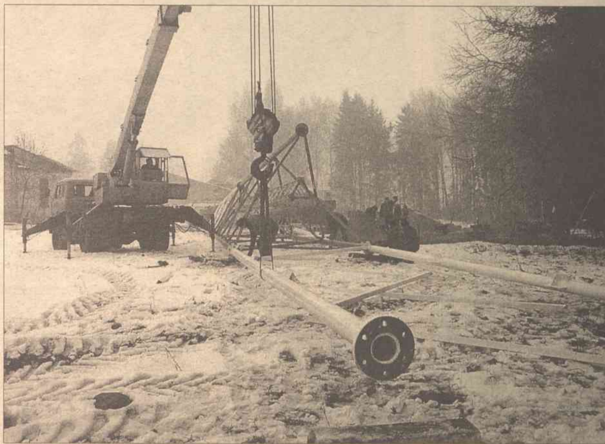
Na placu budowy wszystko jest przygotowane do montowania wieży
