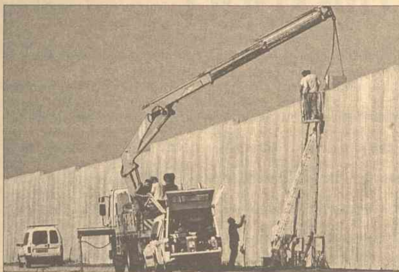
Budowlani izraelscy kontynuują budowę muru, który wywołał krytykę społeczności międzynarodowej oraz papieża Jana Pawła II Fot. EPA-ELTA
