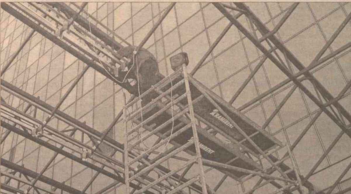
Szklany gmach jeszcze w metalowych „koronkach”
