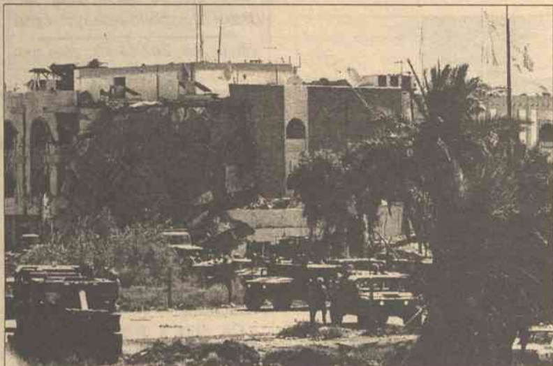
Budynek misji ONZ w Bagdadzie został zniszczony: zawałiła się jego ściana frontowa, a szyby wyleciały na odległość blisko dwóch kilometrów
