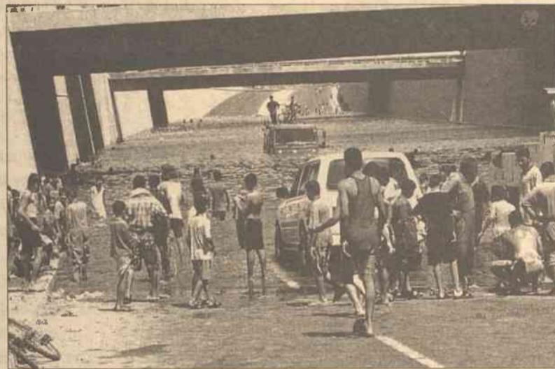
Jeden z głównych wodociągów stolicy Iraku, zaopatrujący w wodę 300.000 mieszkańców, został w niedzielę uszkodzony w wyniku sabotażu. Woda zalała kilka ulic Bagdadu — poinformował Międzynarodowy Komitet Czerwonego Krzyża. Pocisk z ręcznej wyrzutni rakiet przeciwpancernych uszkodził wodociąg o średnicy 160 cm, który doprowadza wodę ze stacji pomp i oczyszczania wody znajdującej się w Sabah Misan, na wschód od Bagdadu. Fot. EPA-ELTA
