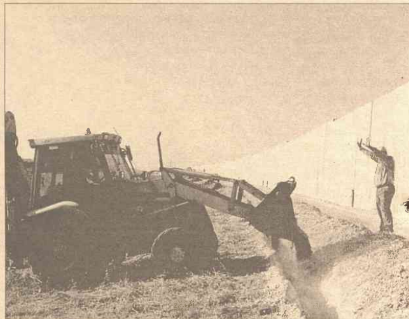
Szaron oświadczył, że mur „będzie nadal budowany, ale tak, by zminimalizować naruszenie prawa Palestyńczyków do swobodnego przemieszczania się”
