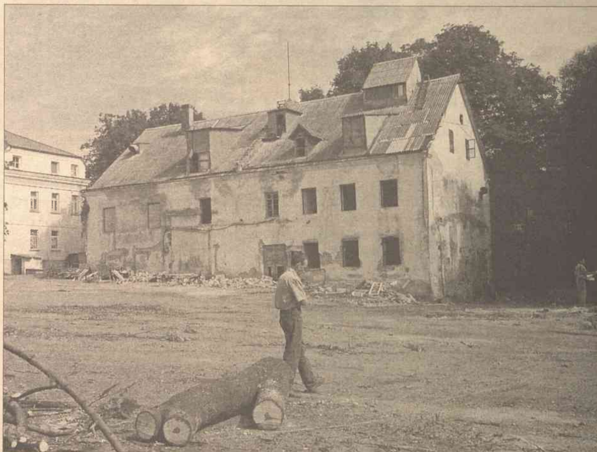
Prace przygotowawcze związane z budową luksusowych mieszkań nad brzegiem Wilii ruszyły na całego
