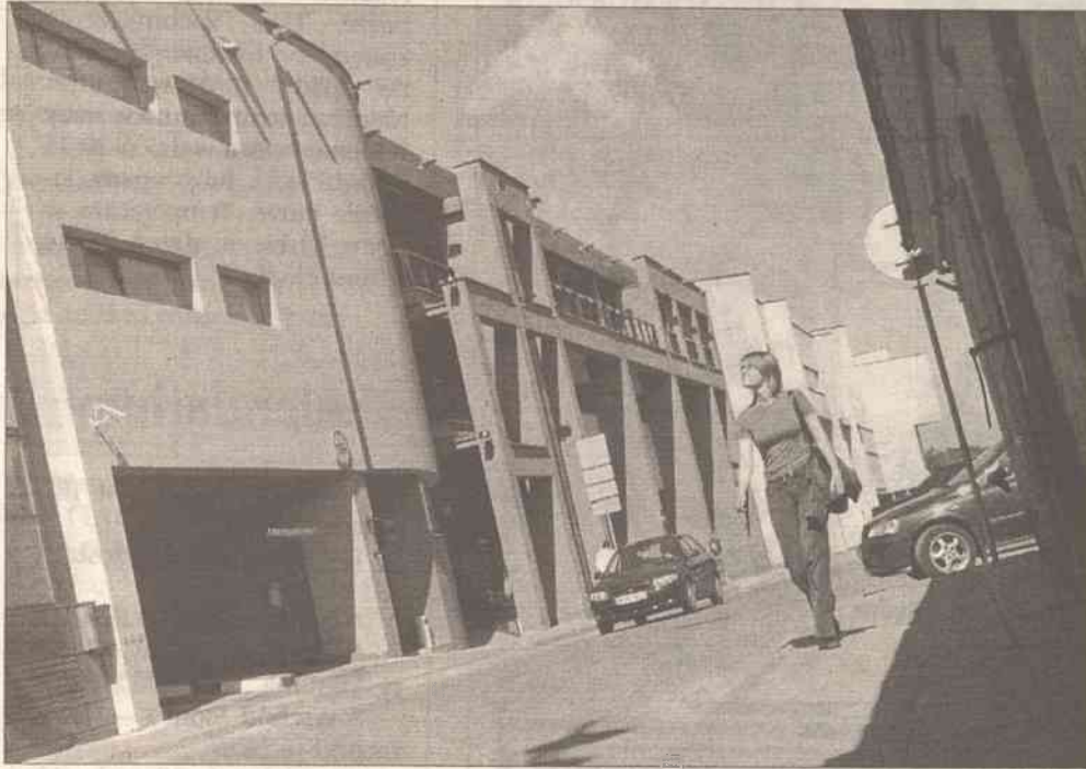
Na miejscu naszego kochanego Domu na Mostowej rozlokowały się garaże
