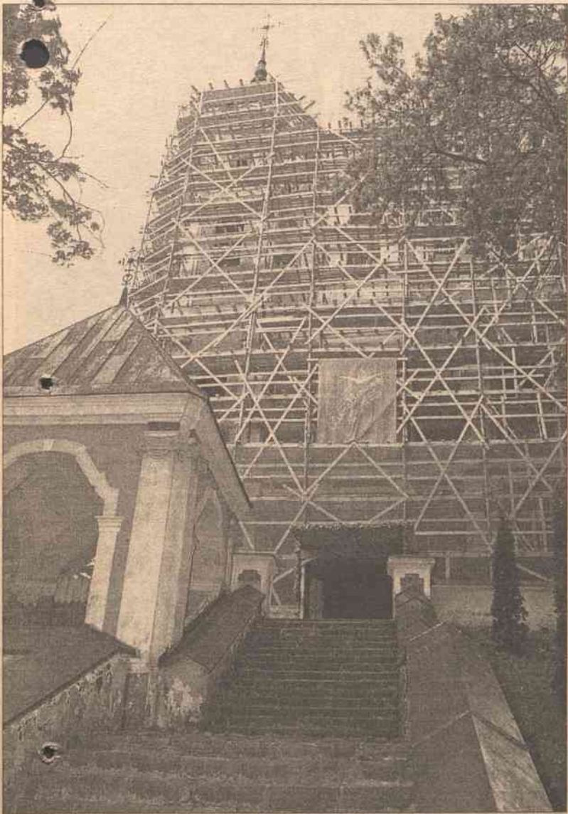
Ledwo ukończono odbudowę Kalwarii, a już zabrano się za remont kościoła
