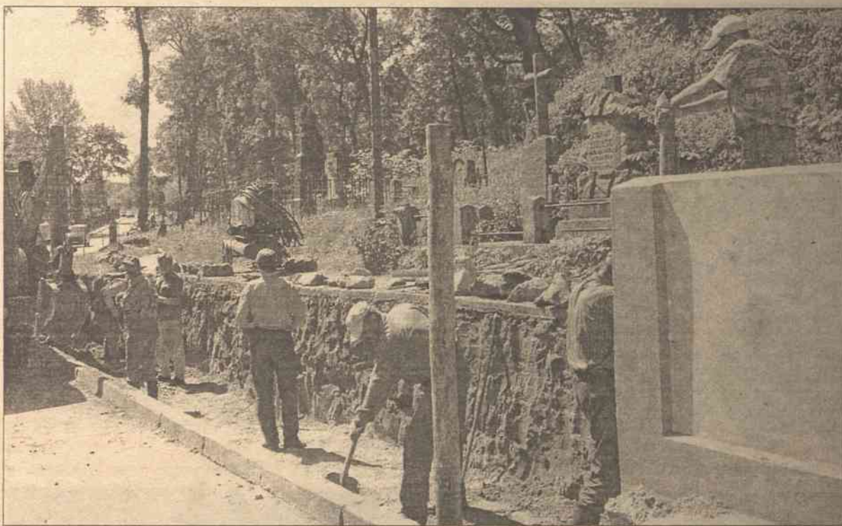
Prace nad ogrodzeniem od ulicy Sukilėlių. Jeszcze spora część cmentarza nie jest ogrodzona. Wszystko zależy od funduszy
