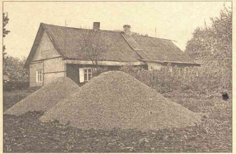
Nowy sąsiad wpadł na „genialny” pomysł zbudowania drogi wprost pod oknami domu pani Wygonowskiej na ziemi jej dziadków Fot. Marian Paluszkiwicz
