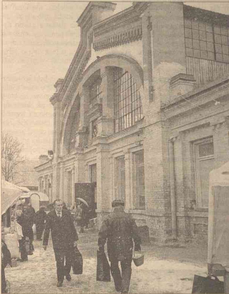
Tak od fasady wygląda obecnie centralna hala
