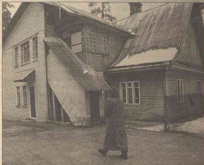
Drewniana część starego domu wewnątrz została "wypatroszona" ze wszystkich ścian i przepierzeń
