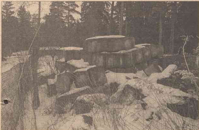
Betonowe bloki wśród dziewiczej przyrody Parku Regionalnego, przeznaczone chyba nie na remont, lecz pod budowę nowego domu
