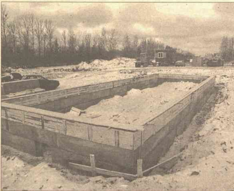
Zakładania fundamentów nie powstrzymał też sąd
