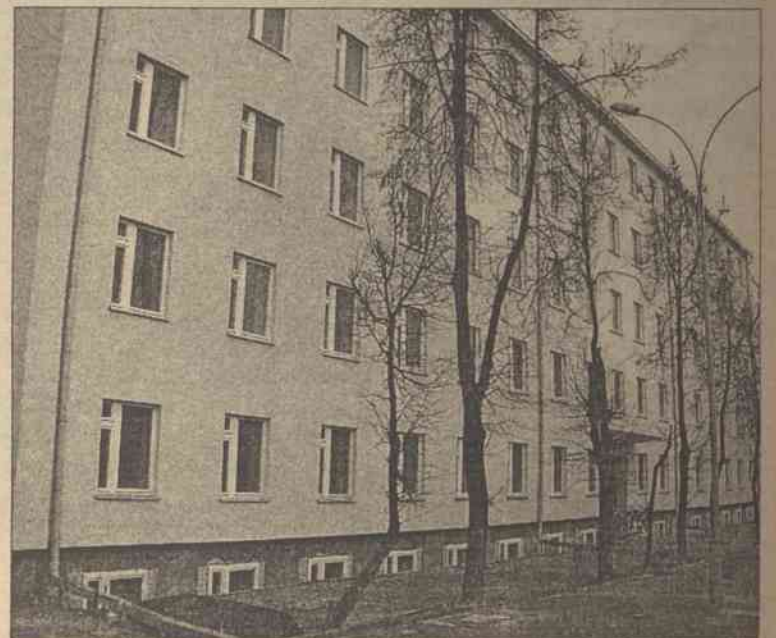
Ocieplone ściany, piękne okna i także wnętrze — to nowy zakład karny przy ul. Rasą
